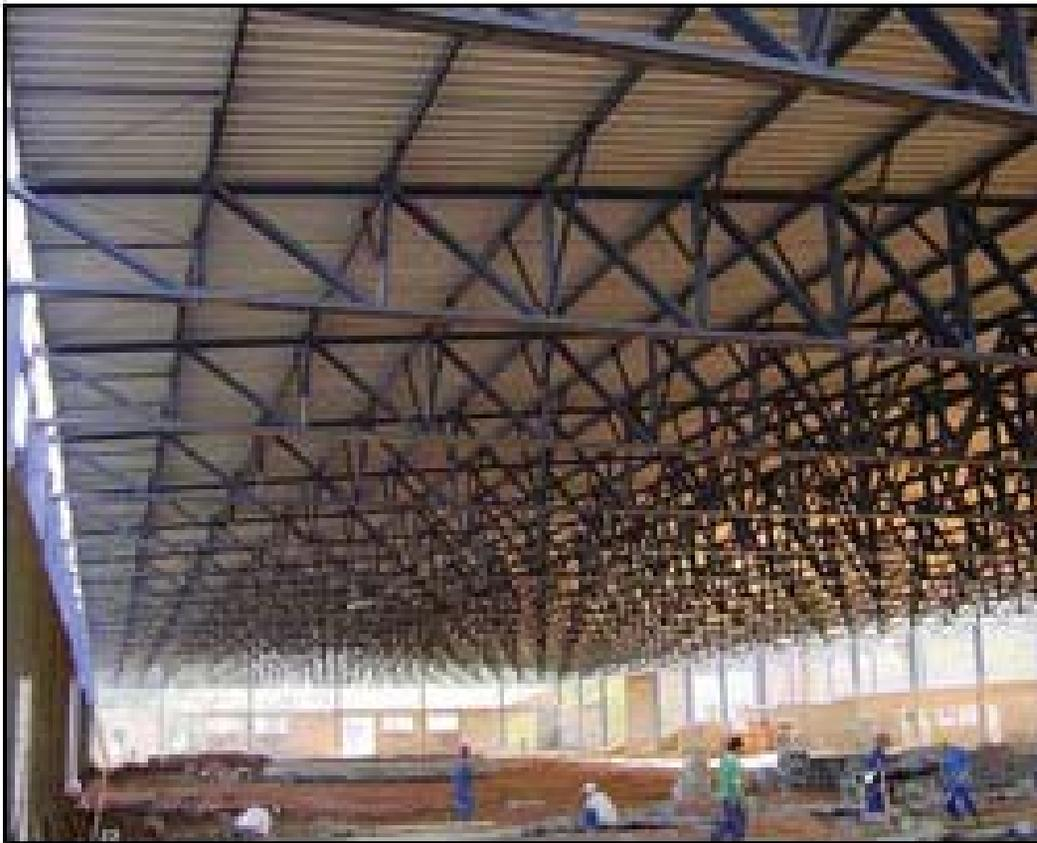
Com projeto, fabricação e montagem da H. Pellizzer, o galpão da Maliber Ind. e Com. Têxtil teve a estrutura metálica de cobertura em duas águas, com vãos livres de 45 metros, com fechamentos verticais e cobertura anexa, apoiadas em pilares metálicos.
